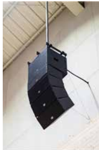
대전 유성여고 체육관 라인어레이 스피커 설치
